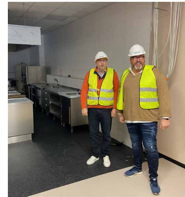
Ralph von Harlessem (rechts), Leiter BTZ Mainz und BTZ Kaiserslautern, mit Michael Kehrer, KSK-Immobilien, auf der Baustellenparty
